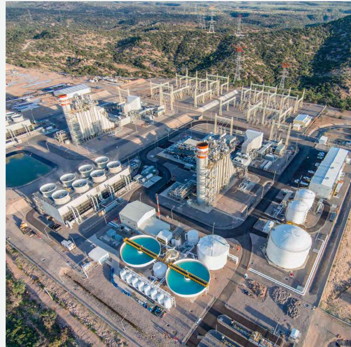
📷 Subestación eléctrica de la Plana de Ciclo Combinado en Nacozari de García, Sonora, México.
