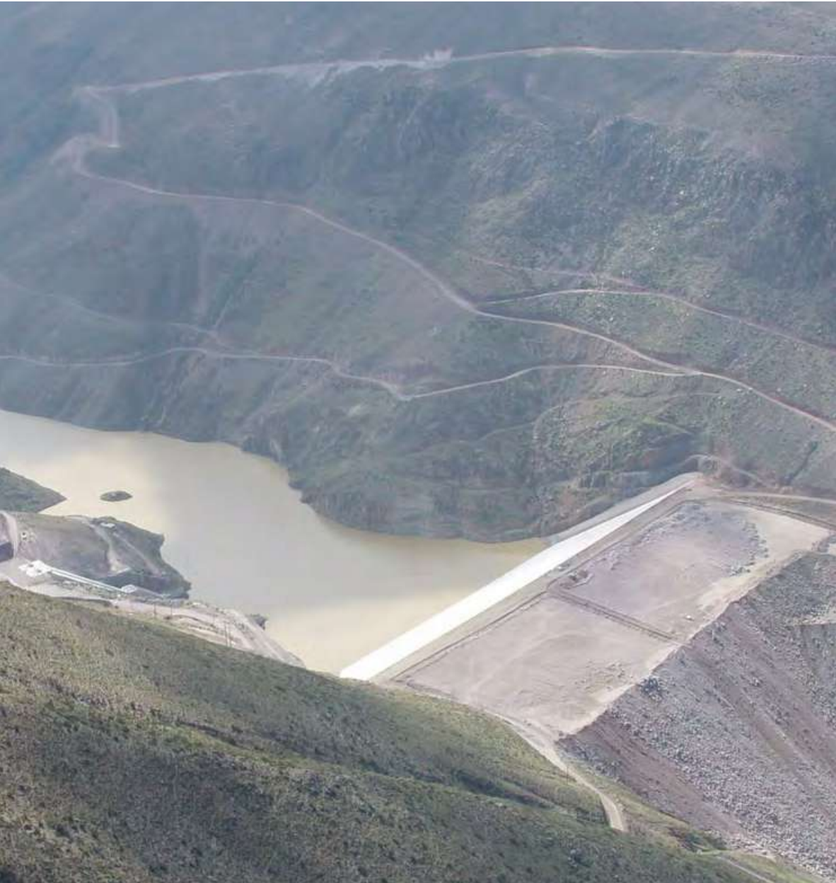
📷 Dique de Torata, mantiene flujo de agua constante a la población en época de estiaje, Unidad Cuajone, Perú.
