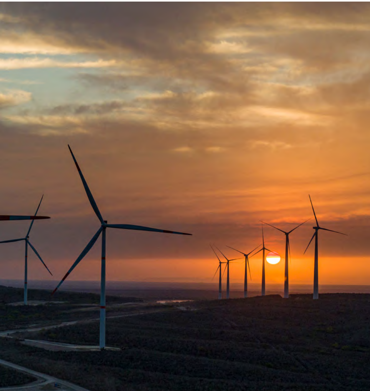
📷 Nuevo parque eólico Fenicias de 168 MW en el norte de México.
