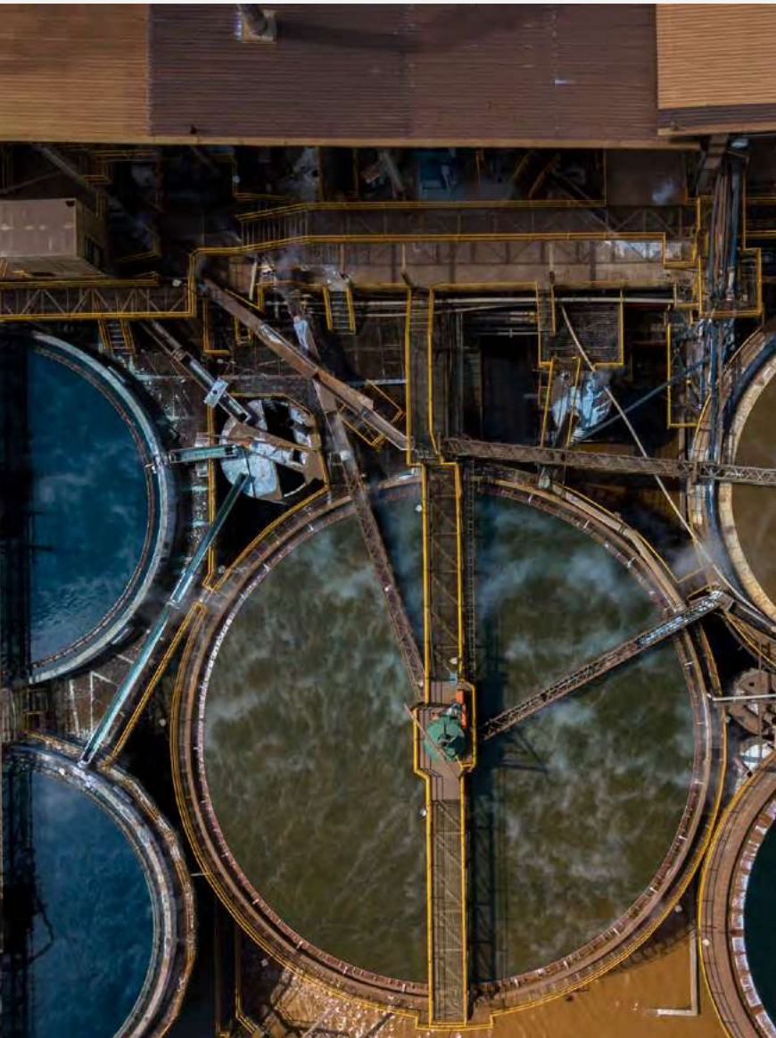
Tanques esperadores de la Planta Concentradora, Unidad Cujone, Perú.
